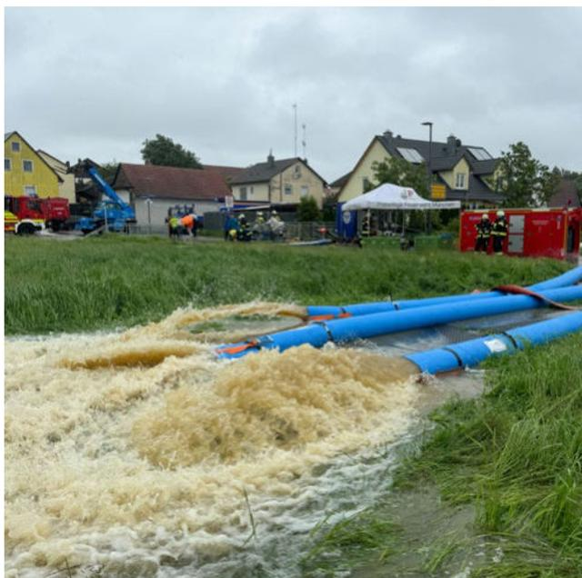
Das Abpumpen von 65.000 Liter Wasser pro Minute entlastet den Steindlbach.
